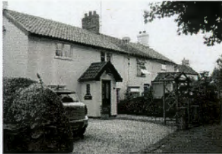
Hawk End Lane Black Fascias & Bargeboards / Black 4 Panel Entrance Door / Chimney
